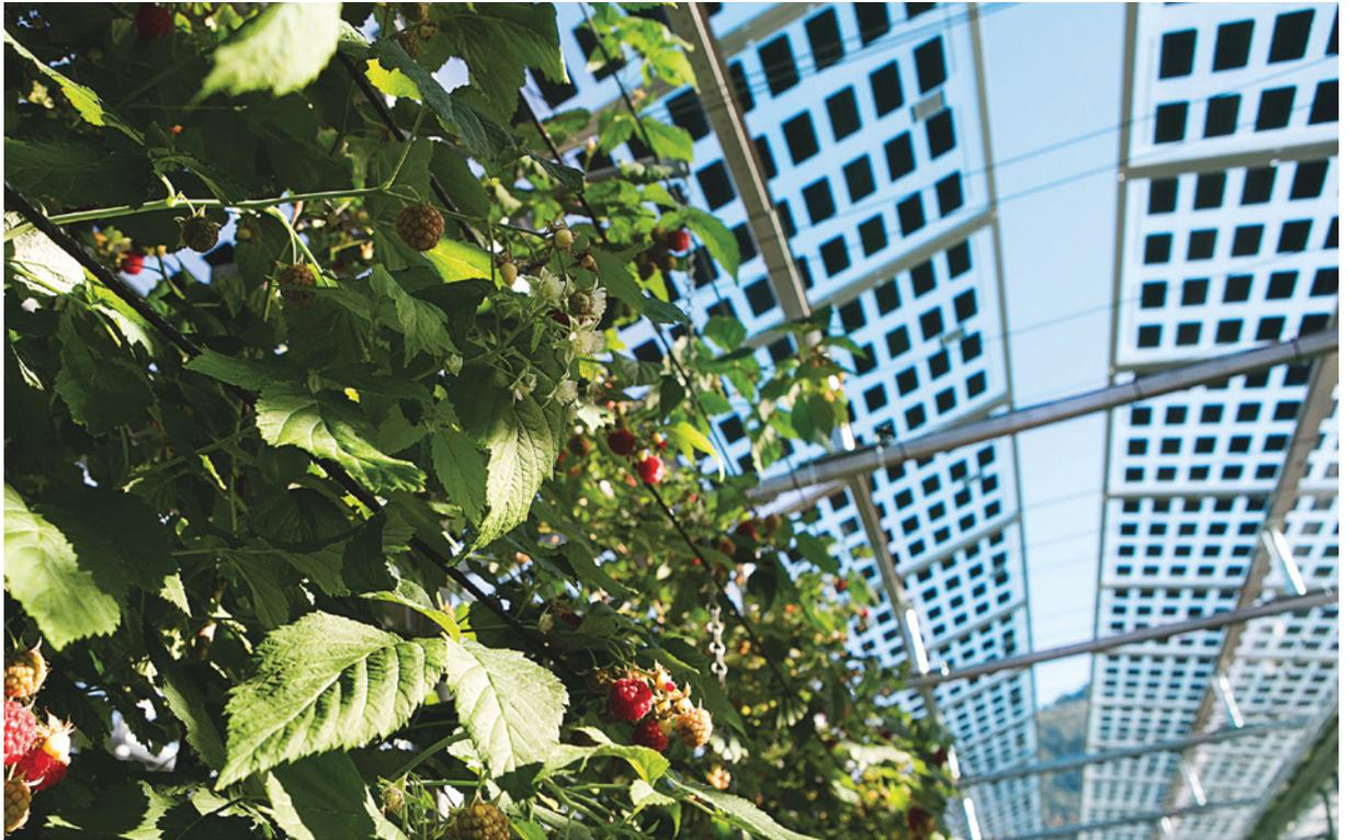
Das Bild zeigt Agri-Photovoltaik über Himbeeren mit semitransparenten PV-Modulen und einen zusammengezogenen Schirm zur Optimierung des Mikroklimas (Bild: Insolight SA).
